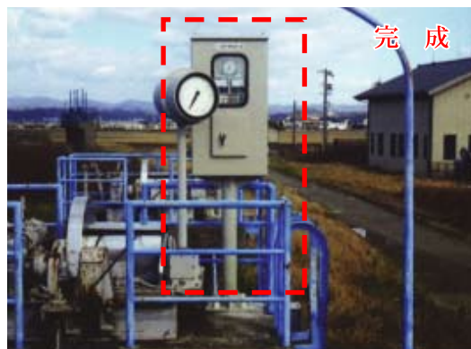
潟端南機側 操作盤更新
