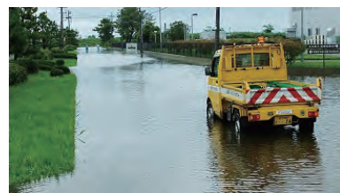
沿岸部の道路冠水状況
