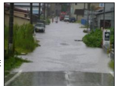
浸水被害状況(平成25年8月23日)
