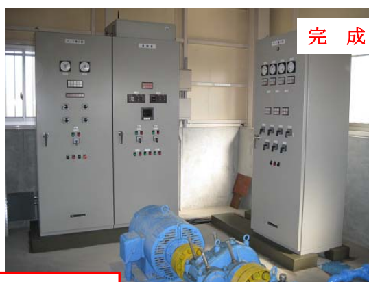
操作盤・補機ゲート盤等の更新
