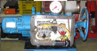
開閉機分解整備
