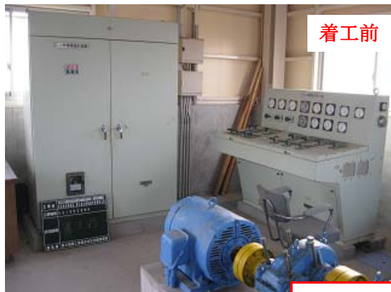
操作盤・補機ゲート盤等の更新
