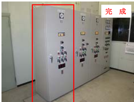
1号制御盤の更新
