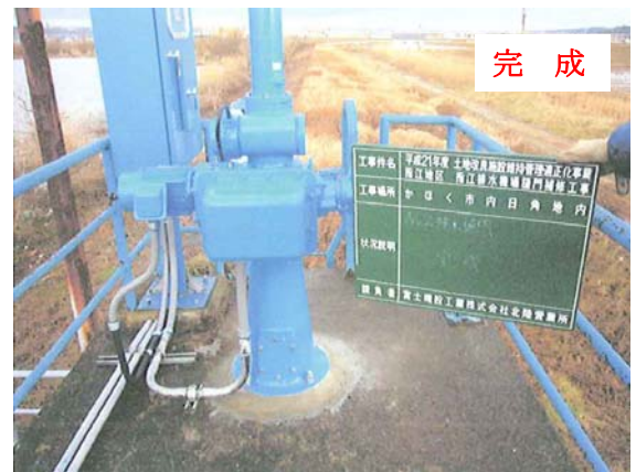
2号樋門巻上げ機取替
