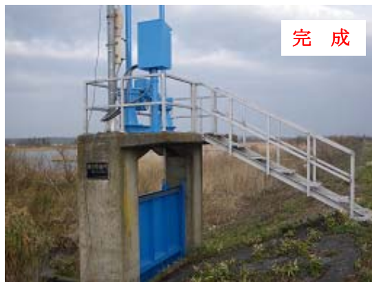
3号塗装・階段手摺取替
