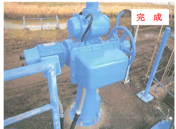
4号樋門巻上げ機取替
