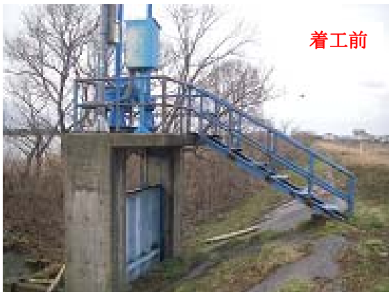
3号塗装・階段手摺取替
