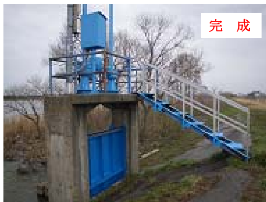
3号塗装・階段手摺取替
