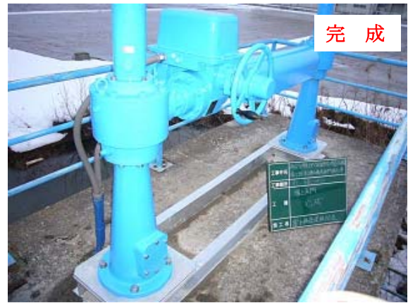
3号樋門巻上げ機取替
