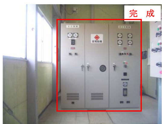
制御盤の移設と高圧盤の更新
