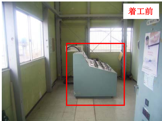
制御盤の移設と高圧盤の更新
