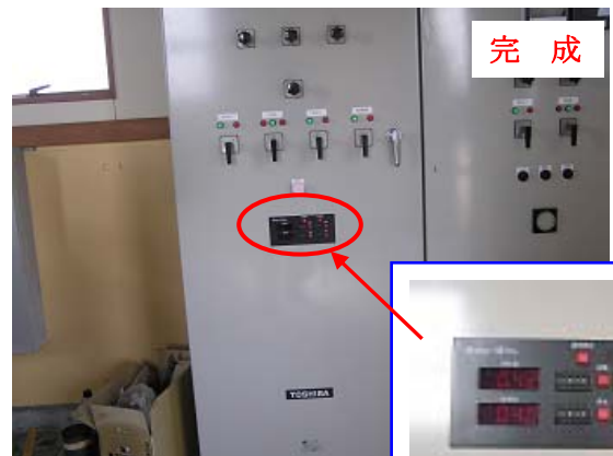
潟端北第1遠方切替装置取付け
