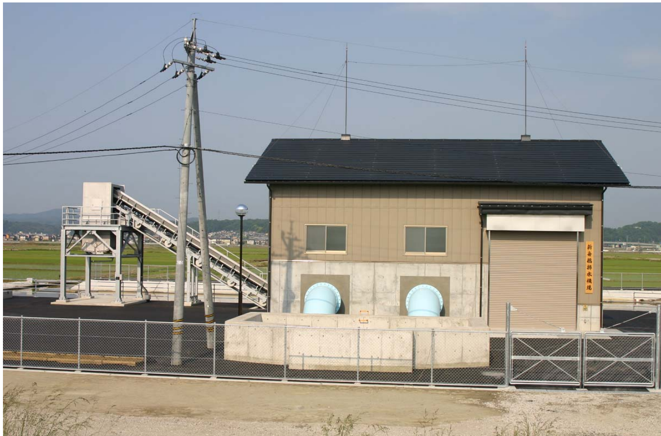
新舟橋排水機場
